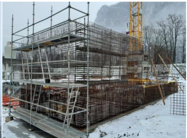
Montage du ferrailage de la bache d'homogénéisation et de la bache à boues digérées
