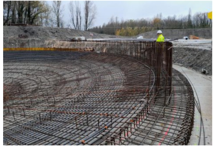
Ferrailage du dallage et du voile du biodigesteur
