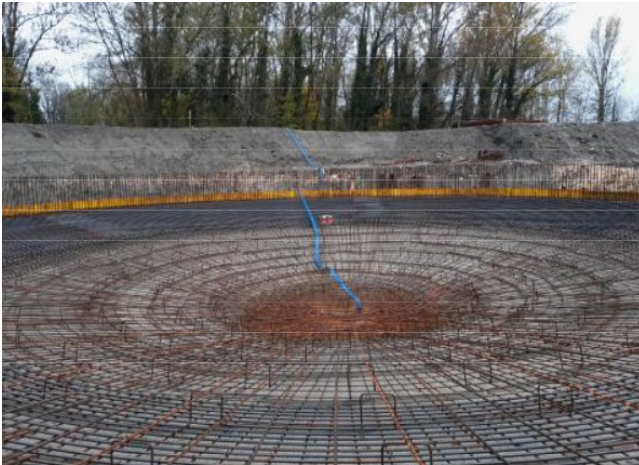
Ferrailage du dallage du biodigesteur
