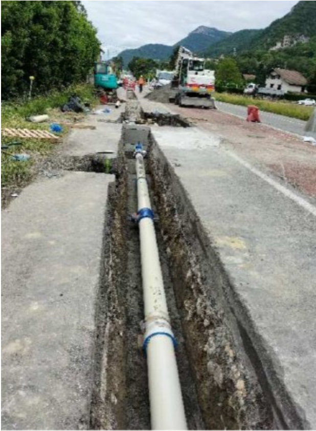
Pose de la conduite principale en Fonte le long de la RD1075
