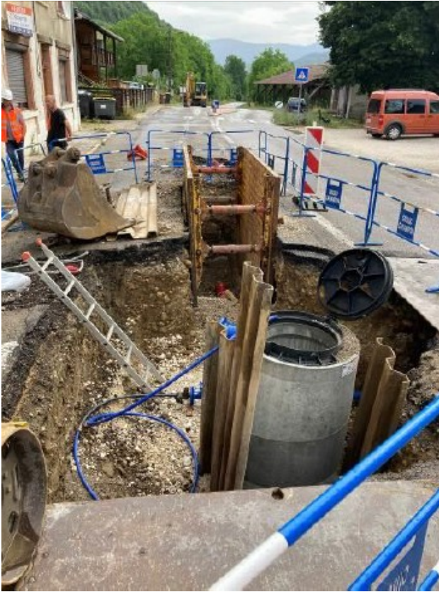
Tranchée d'assainissement en cours sur la RD82
