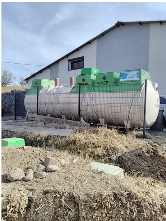
Microstation à culture fixée (20 Equivalents-Habitants)
