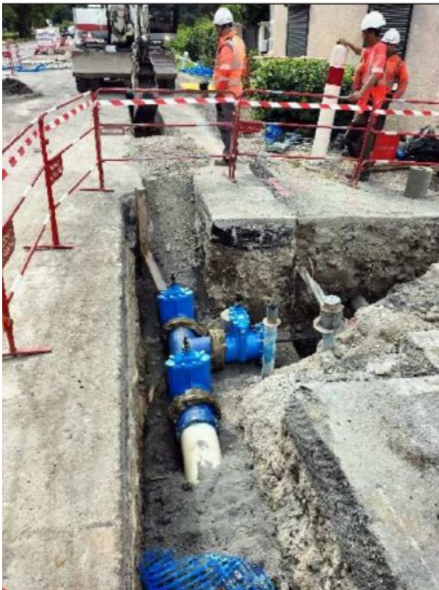
Pose d'un té vanes pour le raccordement d'une antenne
