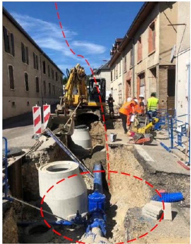
Tranchée d'assainissement en cours sur la RD82 à la jonction avec la route de Balmes
