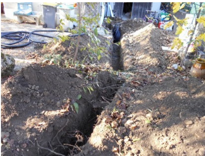
Tranchée de reprise d'un branchement d'eau chez un abonné
