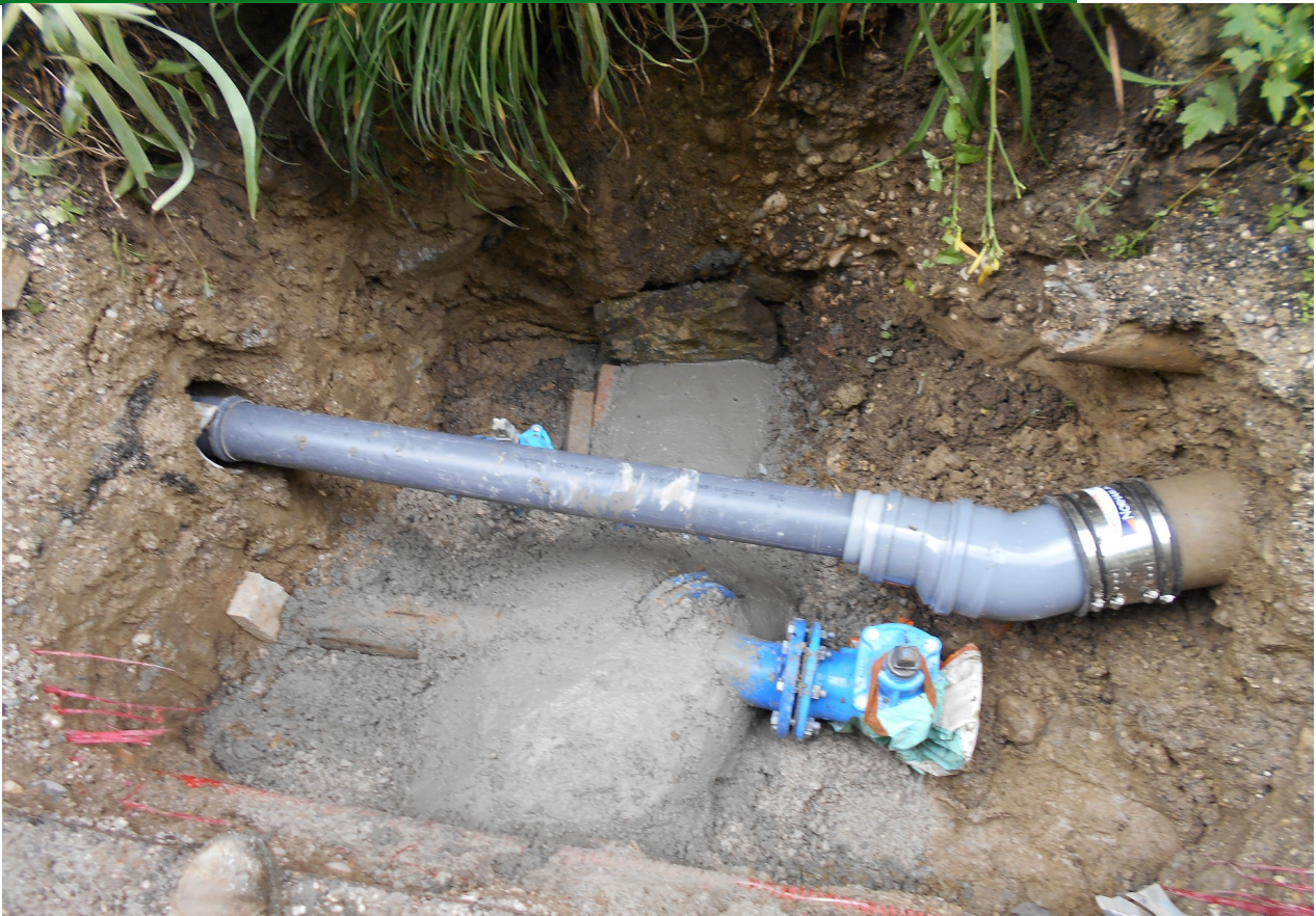
réparation d'un réseau d'assainissement
