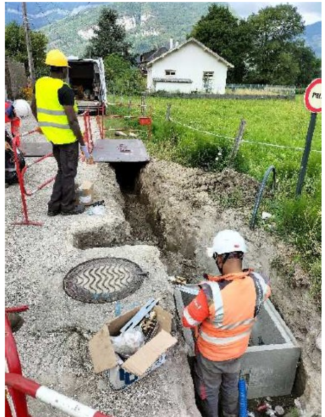
Reprise d'un branchement particulier
