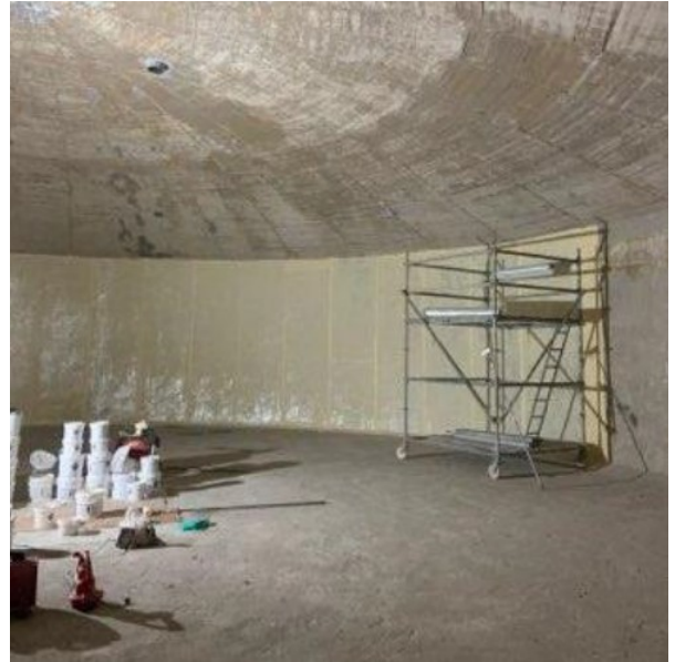
Reprise de l'étanchéité des voiles à l'intérieur de la cuve du réservoir
