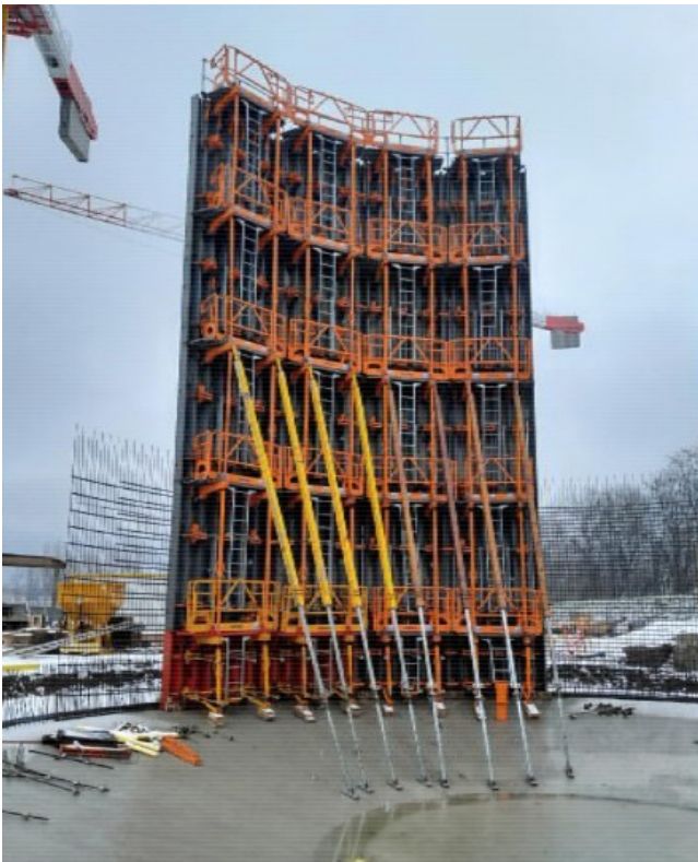
Montage du ferrailage et d'un élément de coffrage des voiles du biodigesteur
