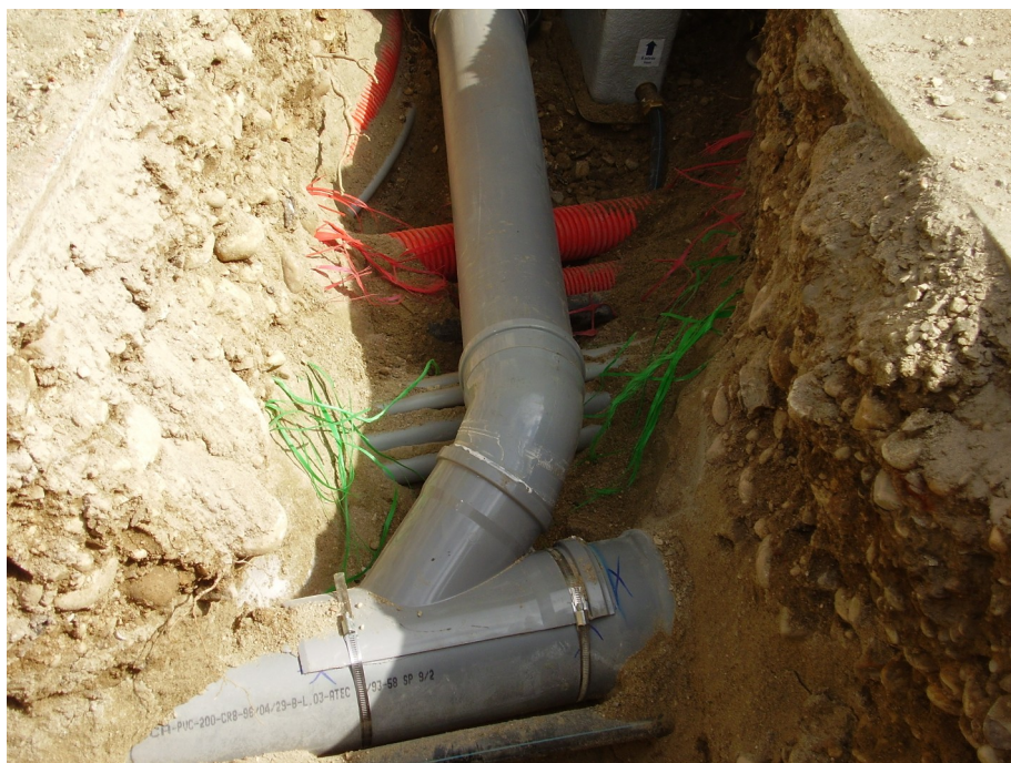
réparation d'un réseau d'assainissement
